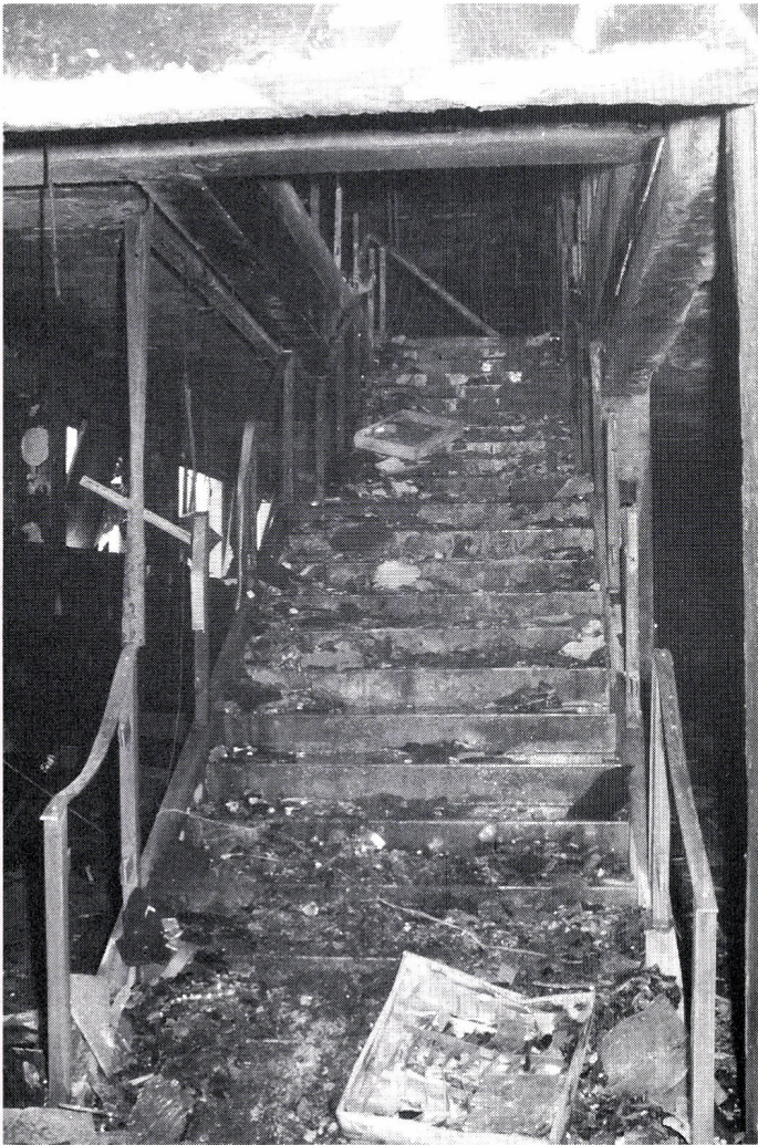
Die offene Kundenstiege vom dritten in den vierten Stock (links) und das vom Keller bis in das Obergeschoß vollkommen offene Stiegenhaus zeigen deutlich, daß es keinen Brandabschnitt gab. Fotos: FF St. Pölten-Stadt
