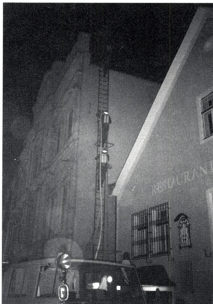
Über die Feuerleiter des Stadttheaters wurde ein Angriff zum Schutz des zu diesem Zeitpunkt schwer gefährdeten Gebäudes vorgenommen. Foto: geli
